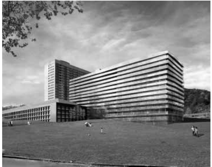
Das geplante Bettenhaus Triemli erfüllt durch den Standard «Minergie-P-Eco» bereits bei seiner Fertigstellung die Anforderungen der 2000-Watt-Gesellschaft.
